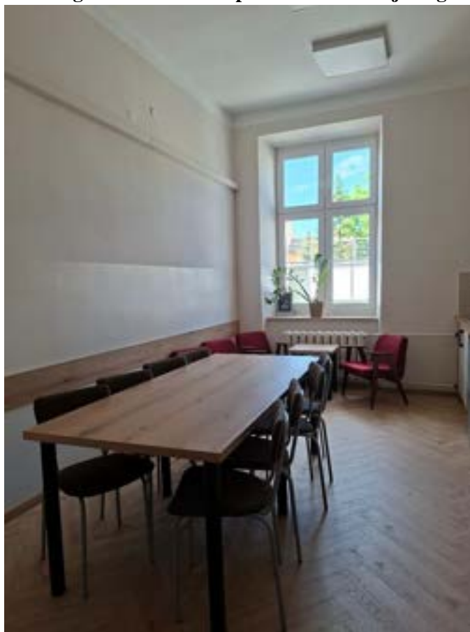
Fotografia 81. Remont pomieszczenia socjalnego
