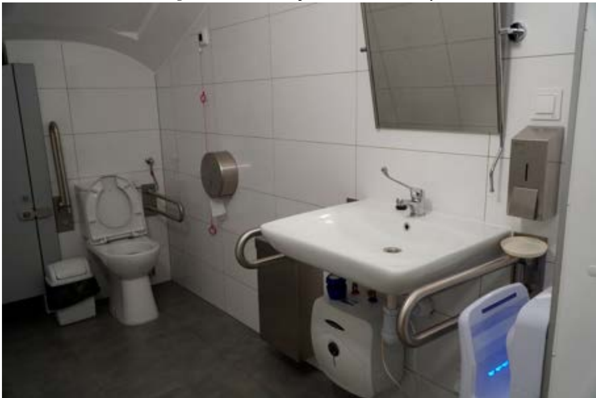
Fotografia 113. Remont pomieszczeń sanitarnych
