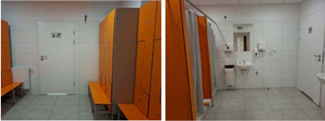
Fotografia 73. Przebudowa pomieszczeń sanitarnych - parter
