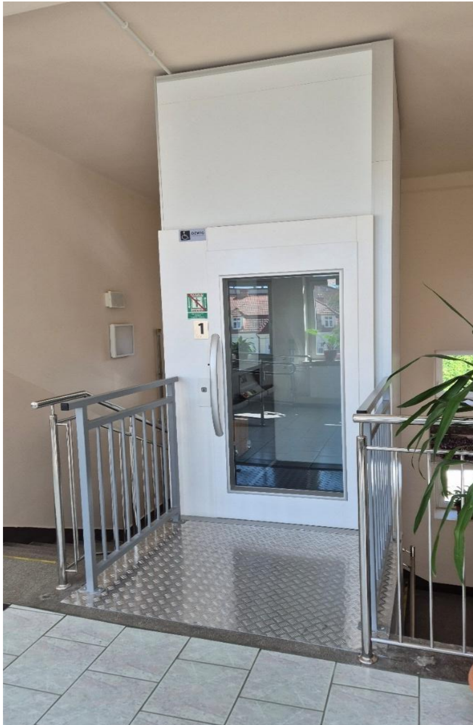
Fotografia 22. Wykonanie platformy pionowej oraz krzesełek schodowych na potrzeby osób z niepełnosprawnościami w I Liceum Ogólnokształcącym w Łańcutie
