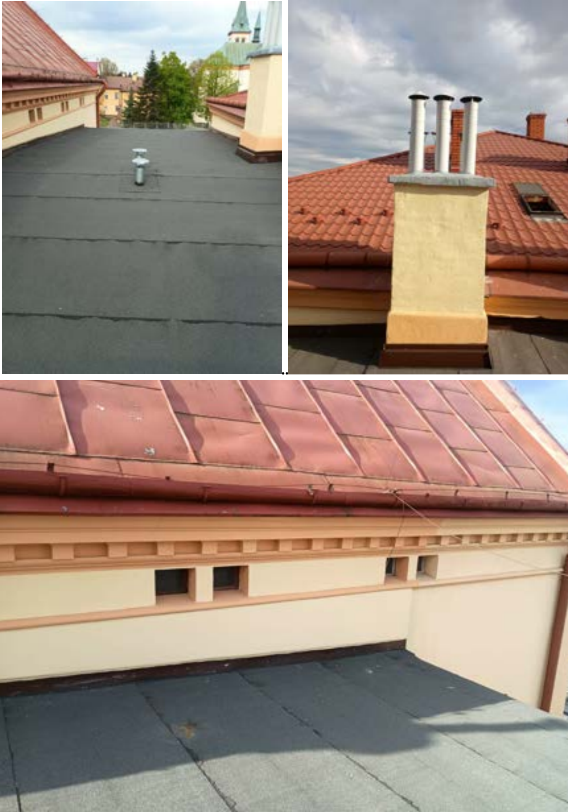
Fotografia 75. Remont pokrycia dachowego przewiązki
