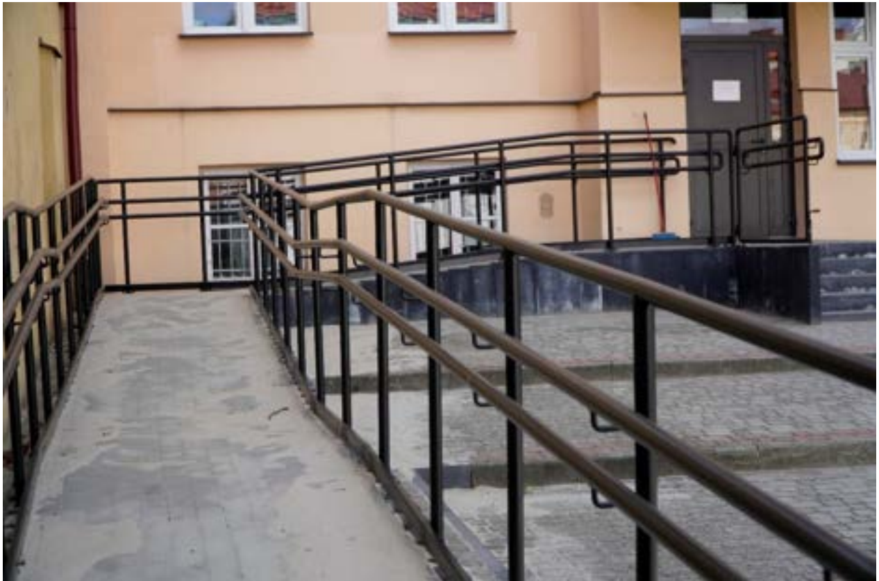
Fotografia 111. Wykonanie podjazdu dla osób niepełnosprawnych
