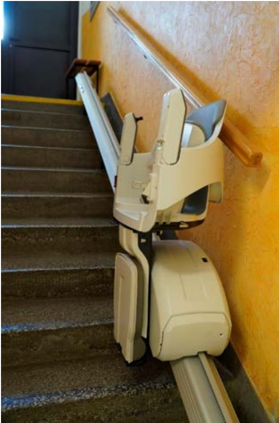
Fotografia 112. Montaż platformy i krzeselek dla niepełnosprawnych
