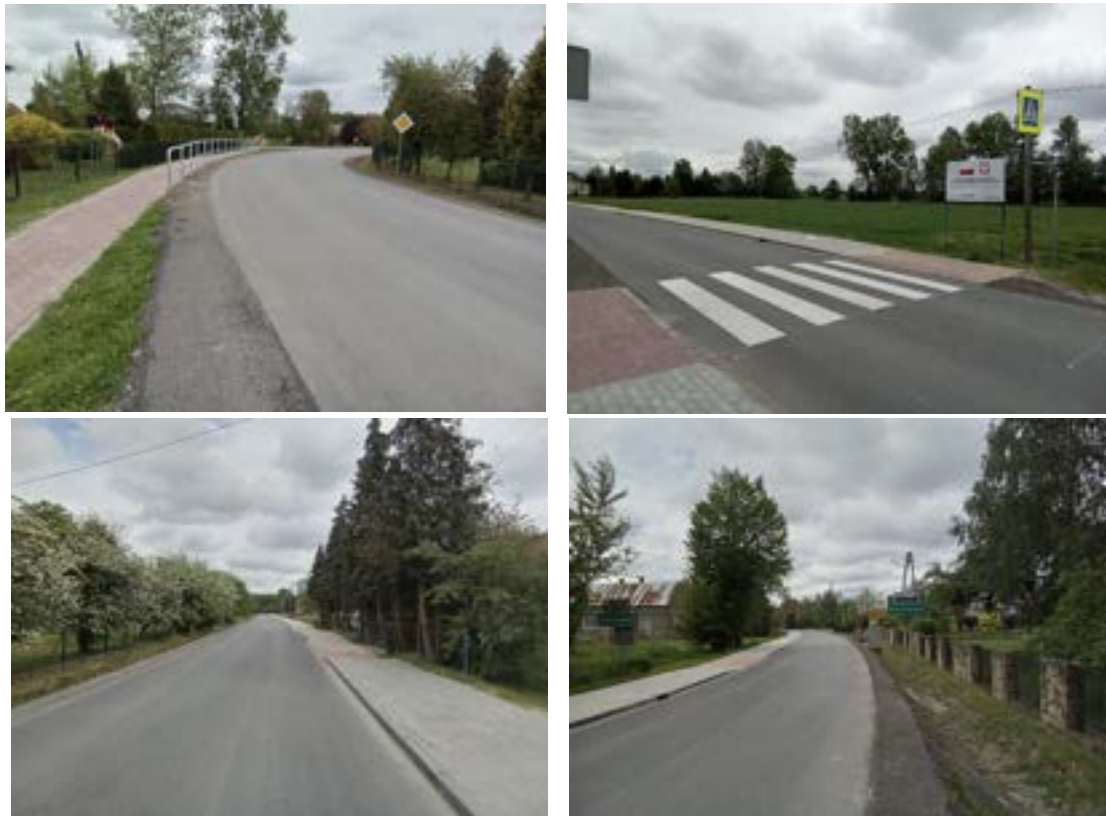
Fotografia 51. Przebudowa drogi powiatowej nr 1518R w Budach Łańcuckich
