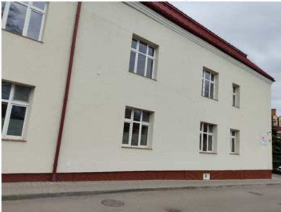
Fotografia 136. Wyremontowane budynki nr 2 i 2A.
