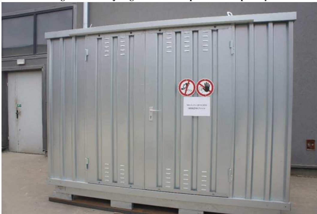
Fotografia 10. Miejsce gromadzenia odpadów niebezpiecznych
