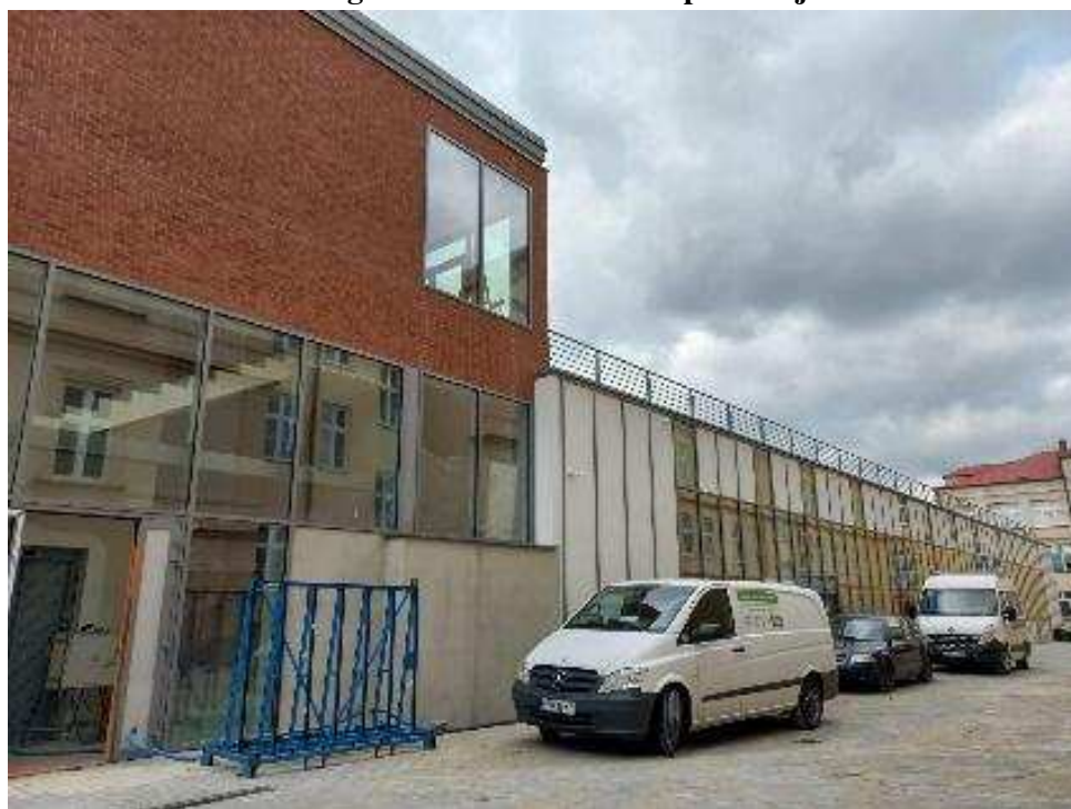
Fotografia 55. Budowa hali sportowej
