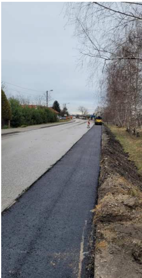
Fotografia 39. Przebudowa drogi powiatowej nr 1275R w Czarnej – budowa utwardzonego pobocza
