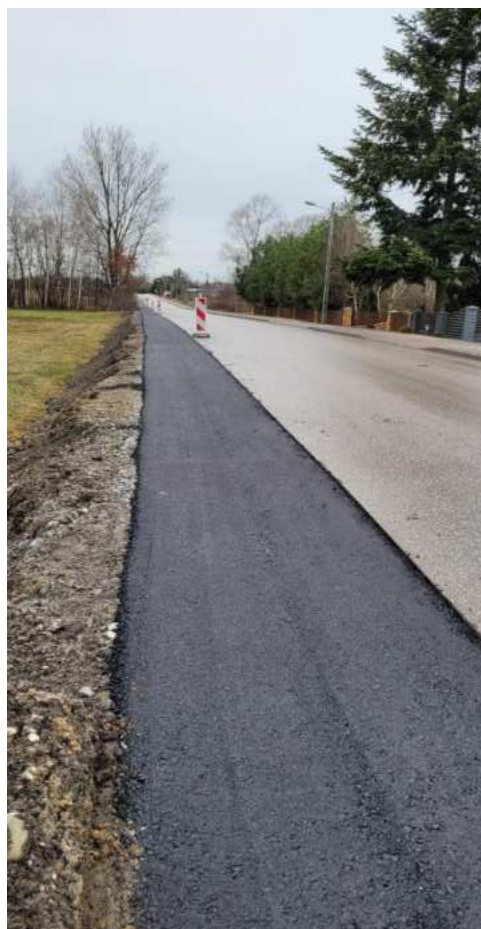
Fotografia 39. Przebudowa drogi powiatowej nr 1275R w Czarnej – budowa utwardzonego pobocza
