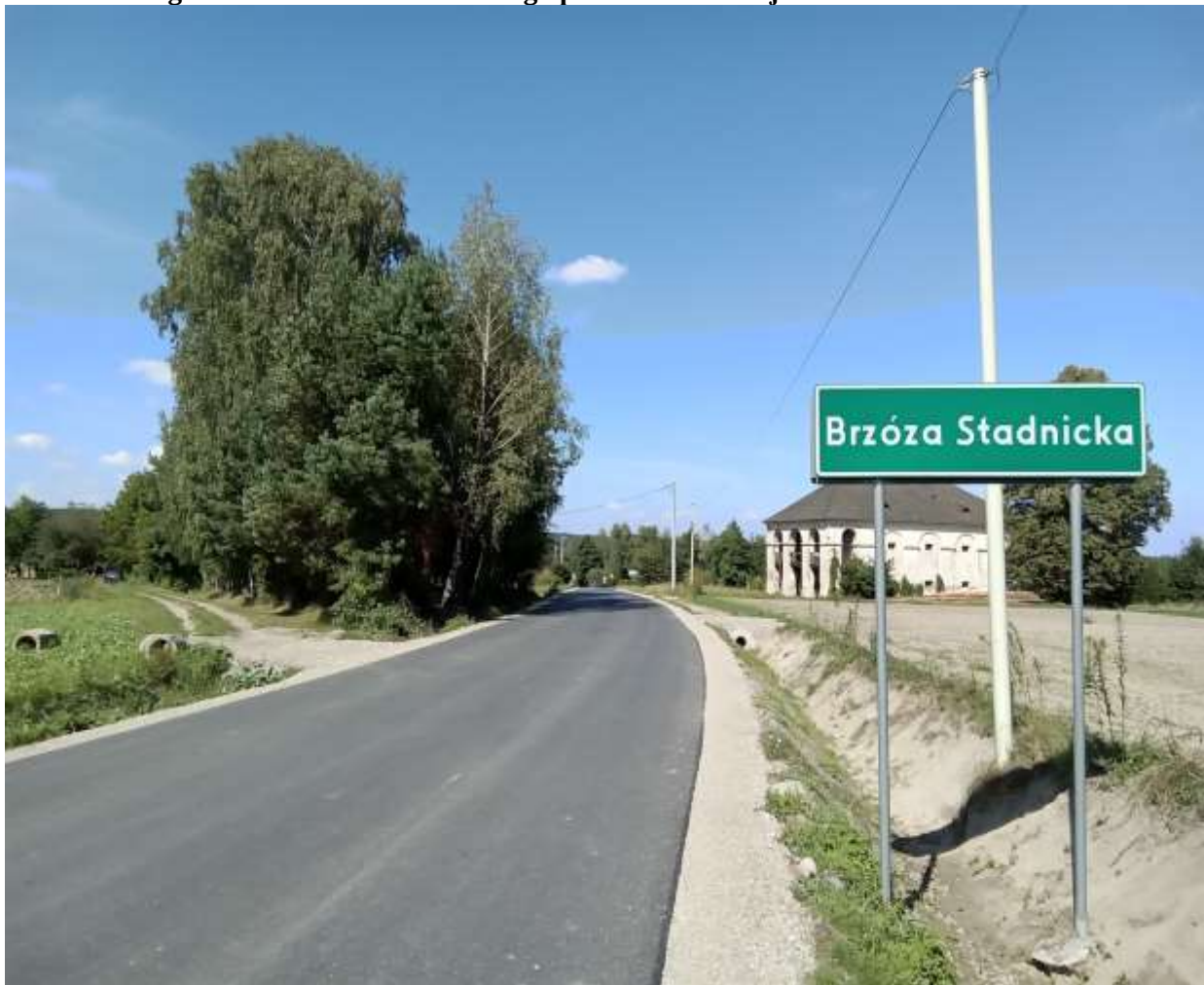
Fotografia 45. Przebudowana droga powiatowa w miejscowości Brzóza Stadnicka
