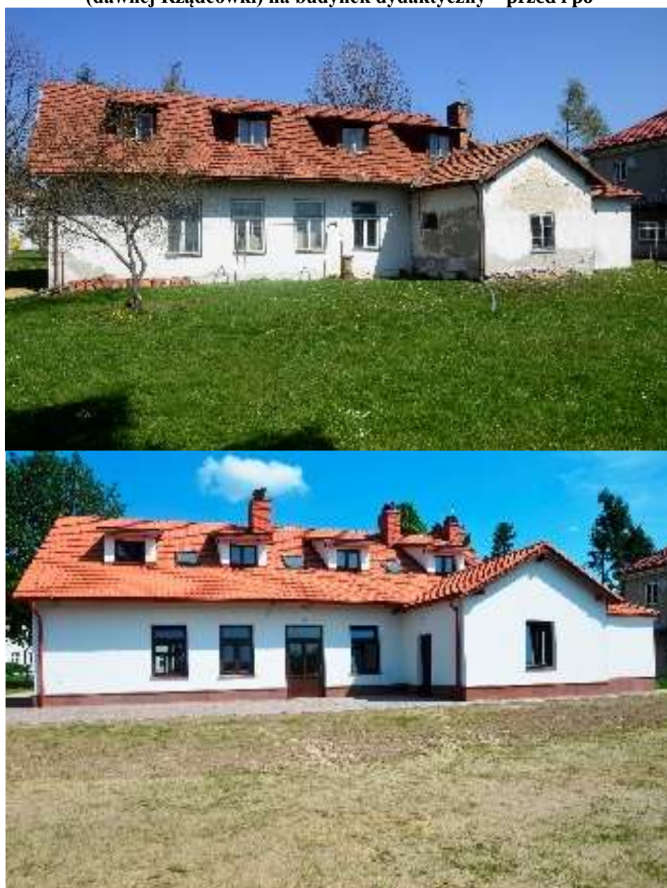
Fotografia 113. Przebudowa i zmiana sposobu użytkowania budynku mieszkalnego (dawnej Rządcówki) na budynek dydaktyczny – przed i po
