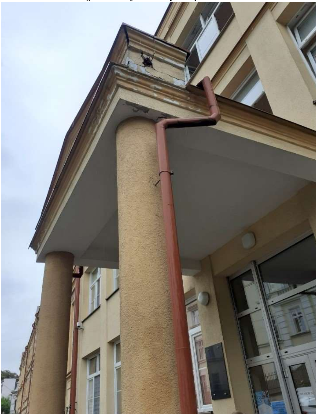
Fotografia 67. Wejście do budynku – przed remontem
