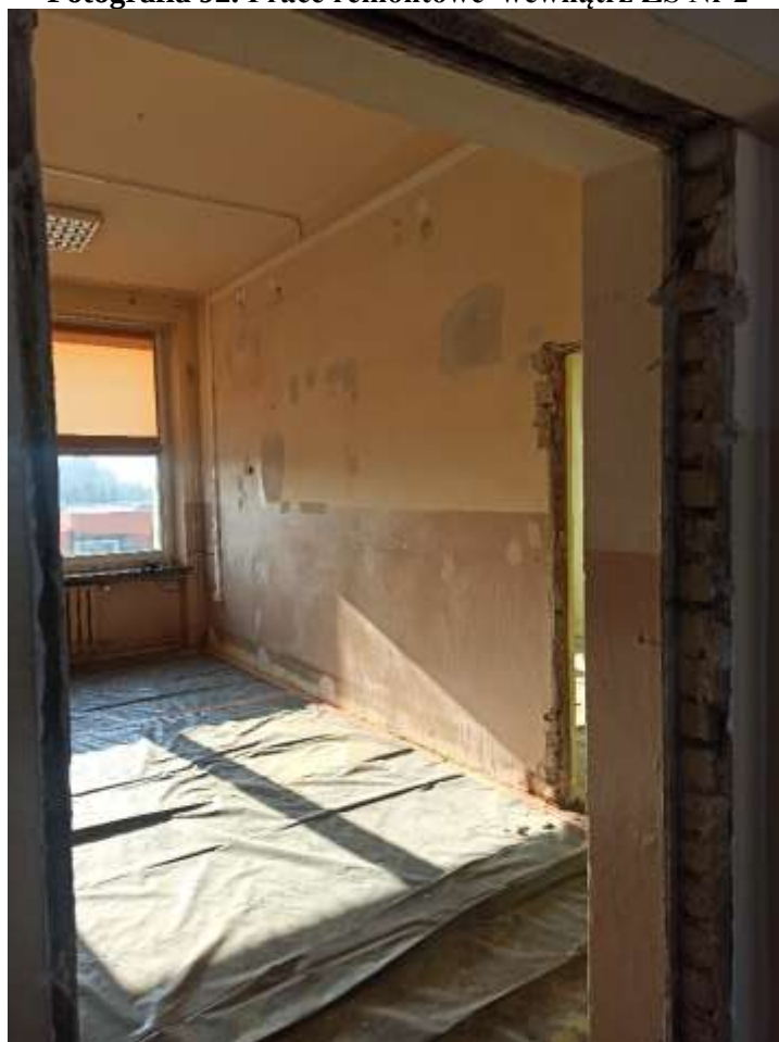
Fotografia 92. Prace remontowe wewnątrz ZS Nr 2
