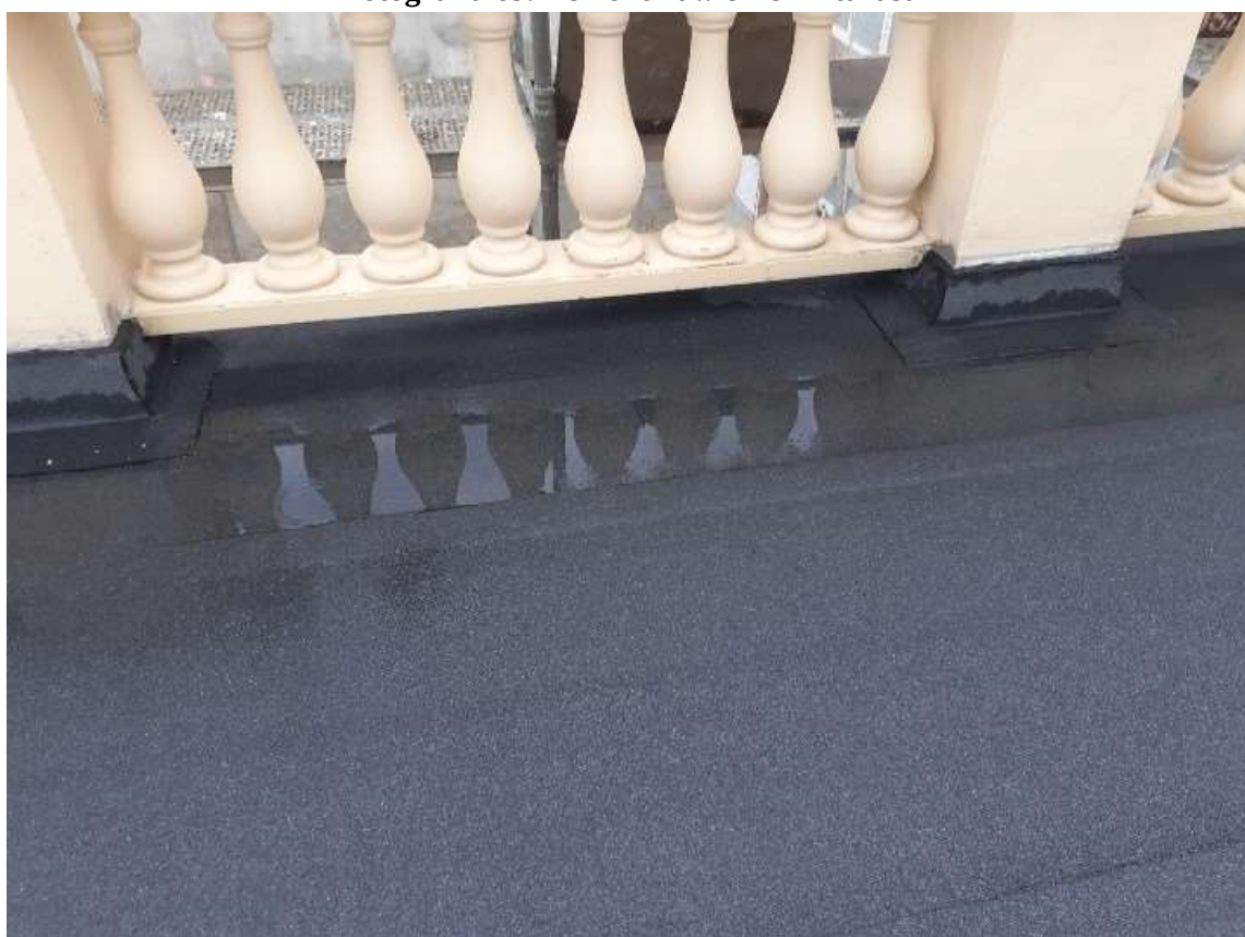
Fotografia 69. Remont nawierzchni tarasu
