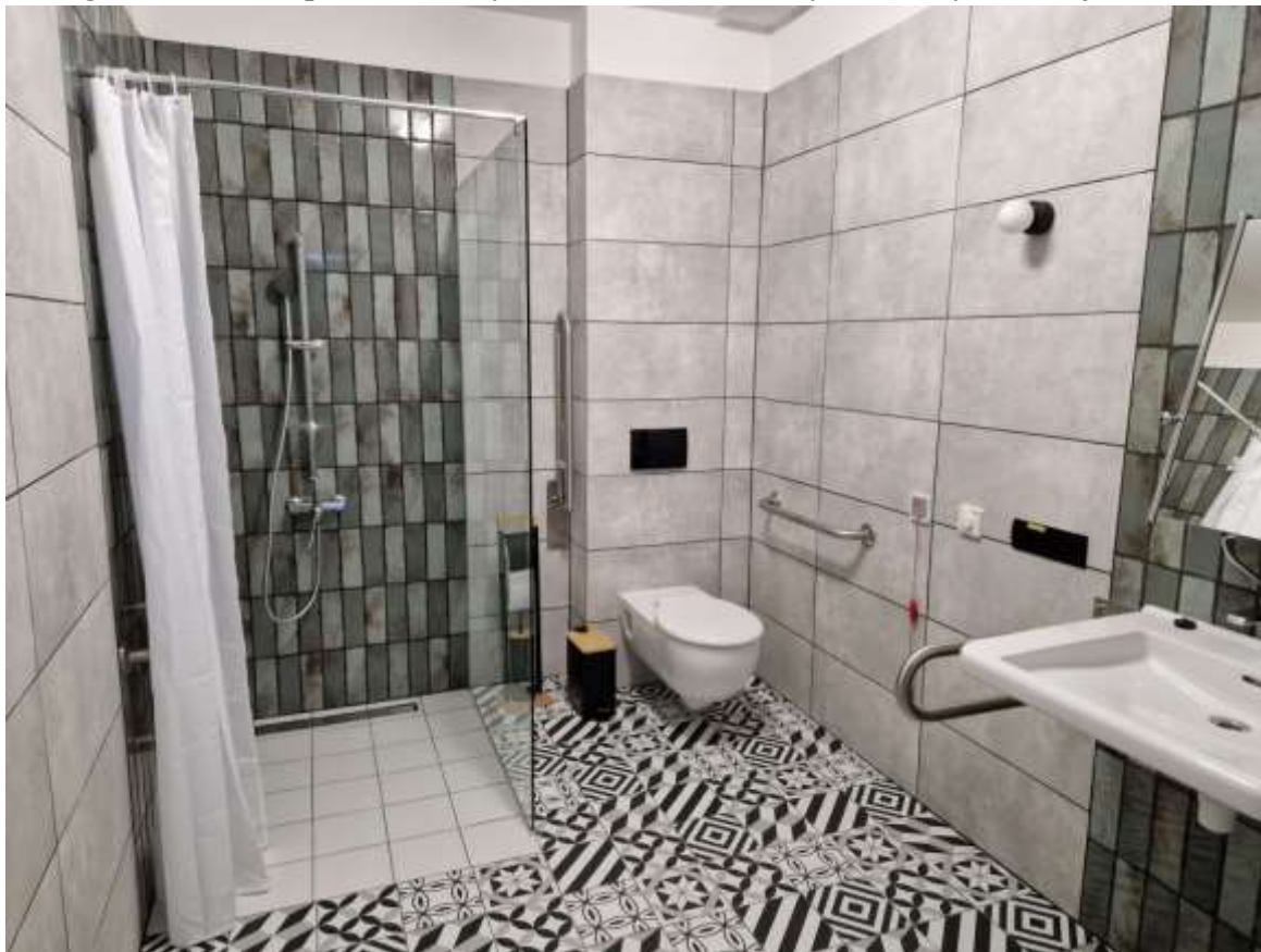
Fotografia 7. Widok przebudowanych sanitariatów w budynku Bursy Szkolnej w Łańcucie
