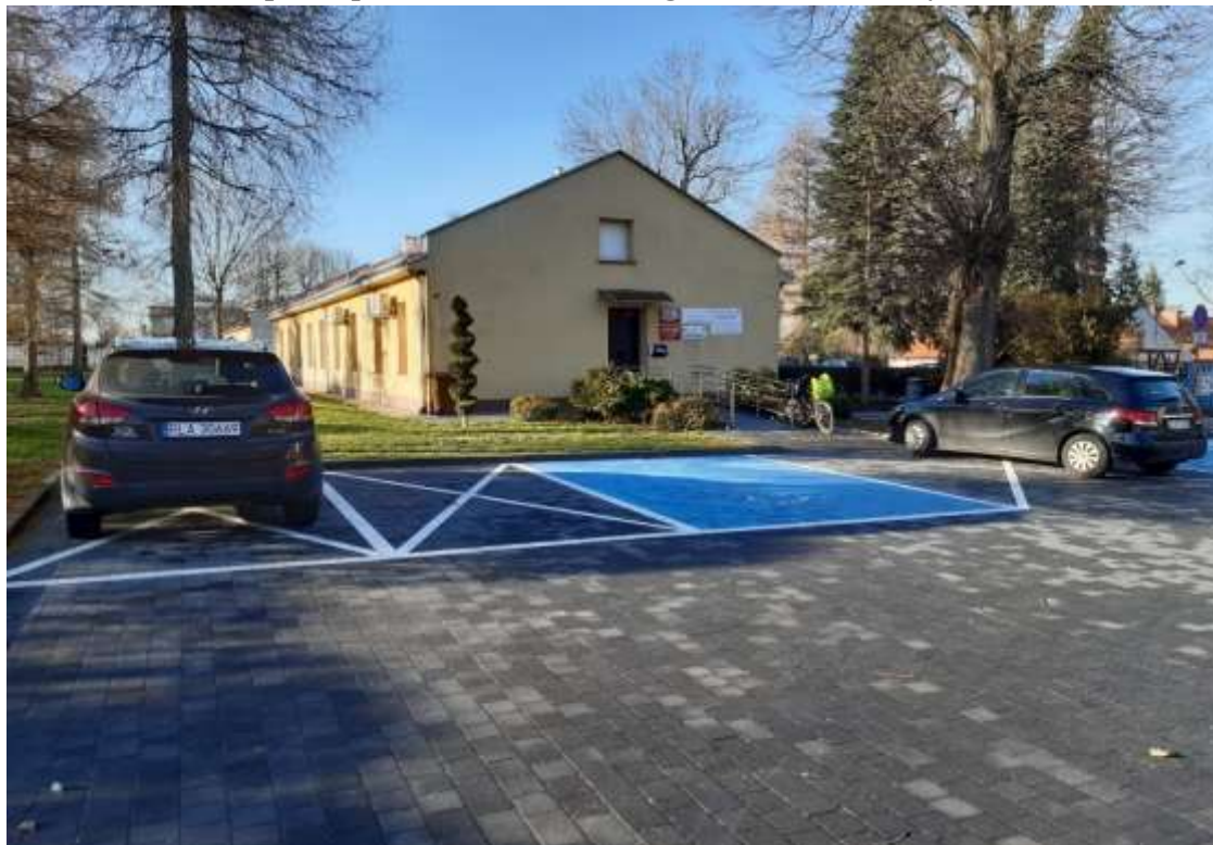
Fotografia 12. Widok na zmodernizowany podjazd przed budynkiem Powiatowego Zespołu ds. Orzekania o Niepełnosprawności i Powiatowego Centrum Pomocy Rodzinie w Łańcucie
