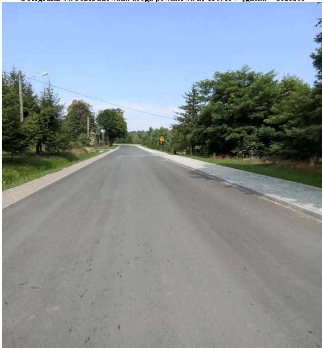
Fotografia 44. Przebudowana droga powiatowa nr 1369R Węgliska – Trzeboś
