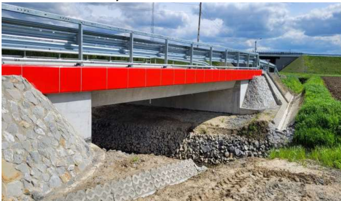
Fotografia 46. Przebudowany most w ciągu drogi powiatowej nr 1520R w miejscowości Wola Dalsza na rzece Sawa
