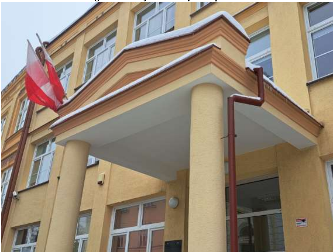
Fotografia 68. Wejście do budynku – po remoncie
