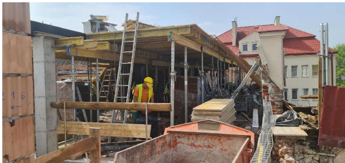
Fotografia 109. Prace przy przebudowie istniejącego budynku po byłych oddziałach Chirurgii, Ginekologii, Położnictwa i Neonatologii Szpitala Powiatowego w Łąncucie
