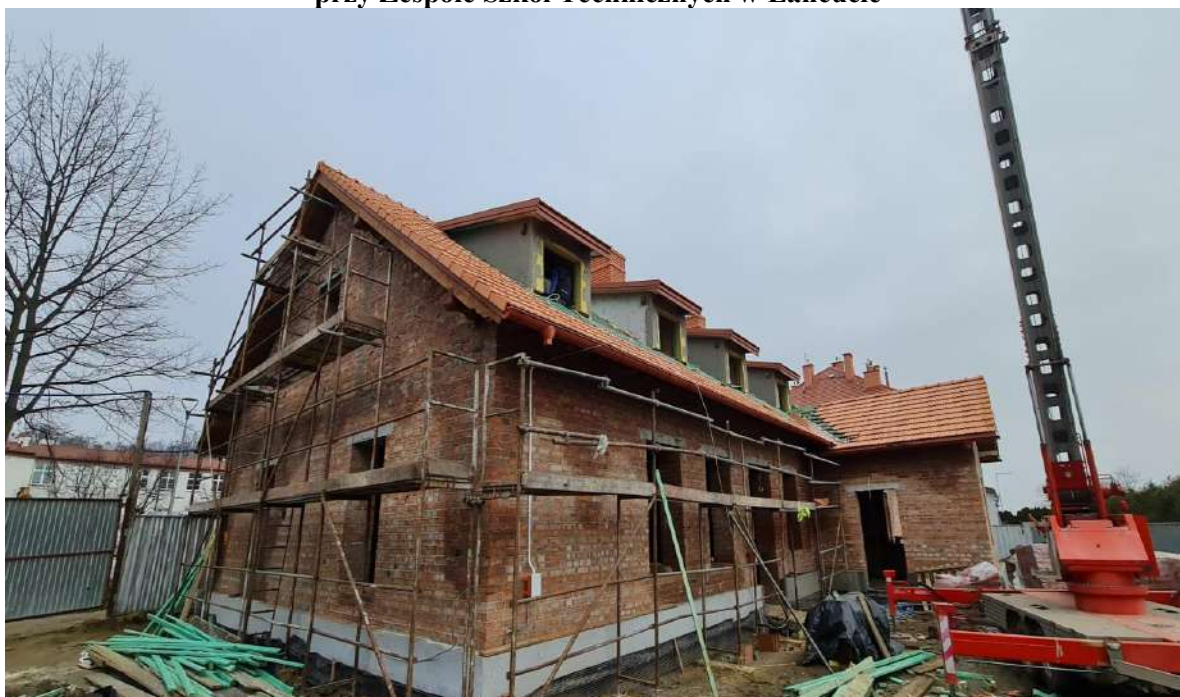
Fotografia 6. Prowadzone prace przy budynku byłej Rządcówki przy Zespole Szkół Technicznych w Łańcucie
