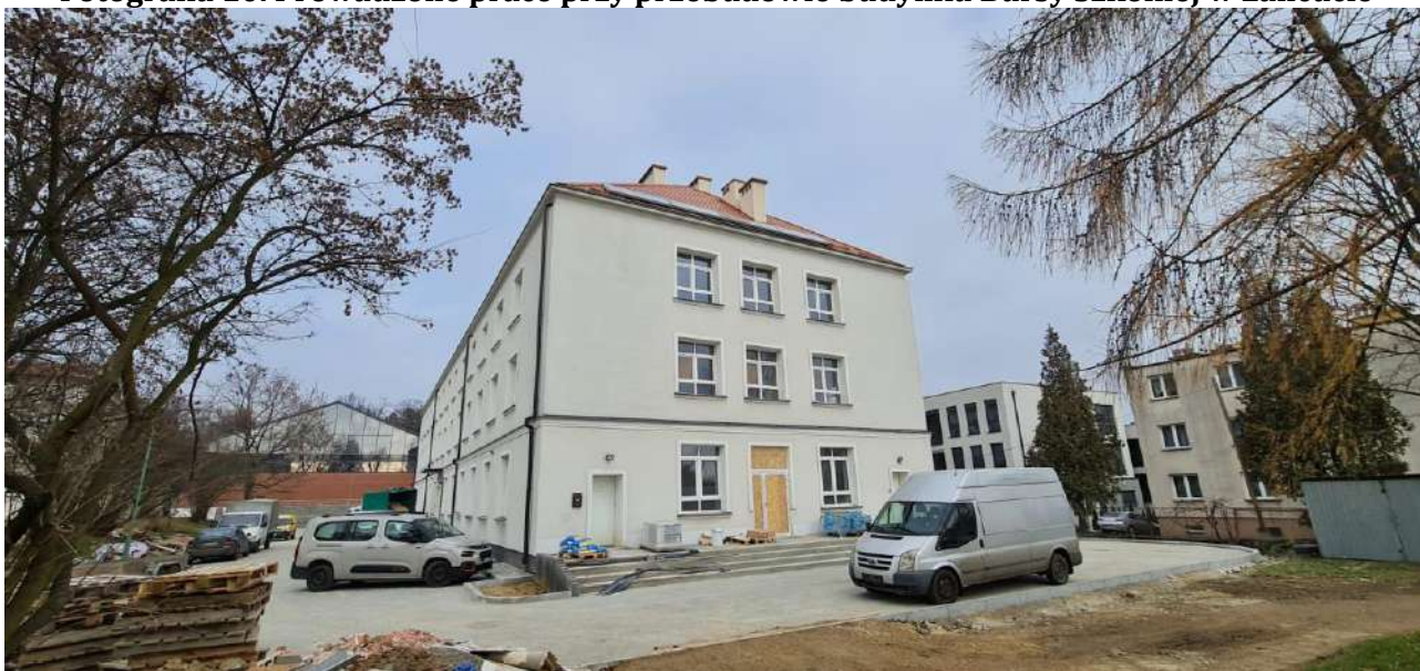
Fotografia 10. Prowadzone prace przy przebudowie budynku Bursy Szkolnej w Łańcucie
