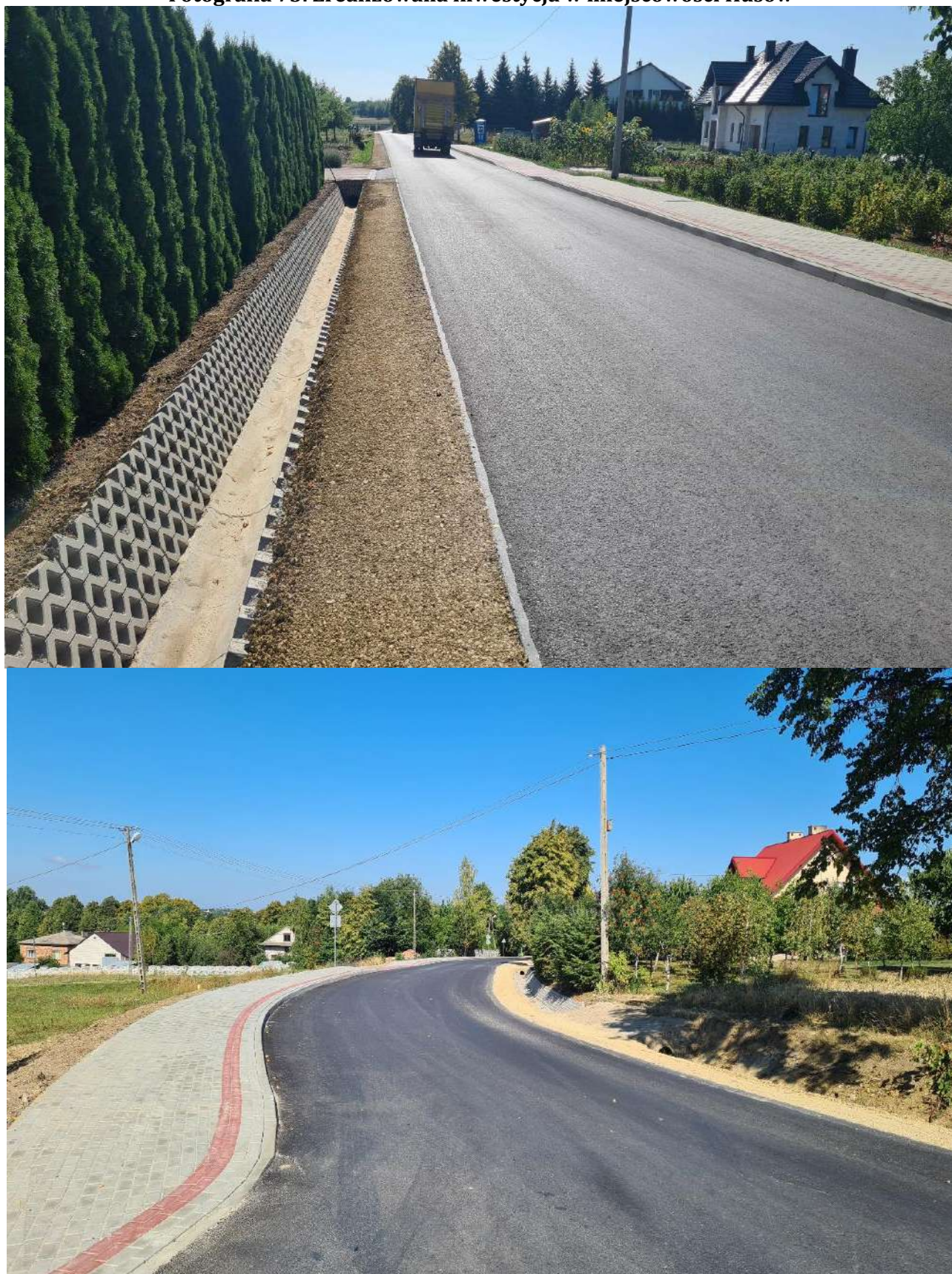
Fotografia 73. Zrealizowana inwestycja w miejscowości Husów
