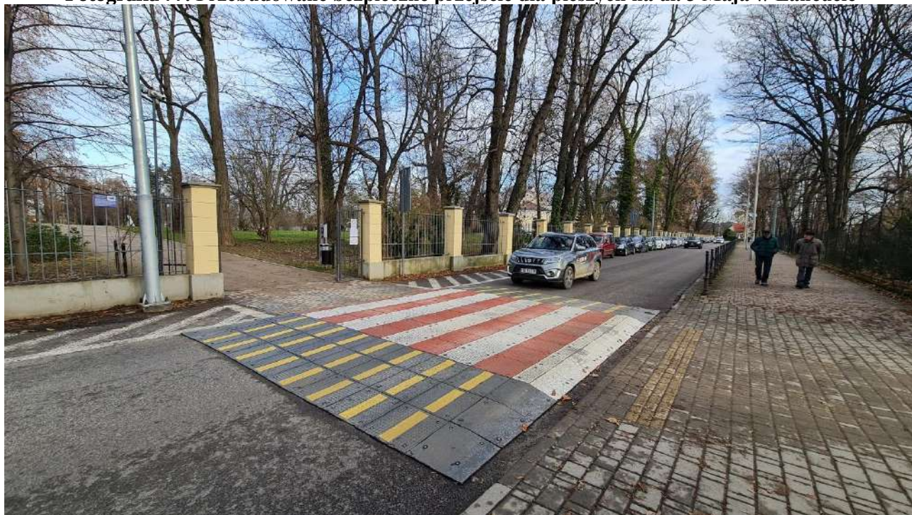
Fotografia 77. Przebudowane bezpieczne przejście dla pieszych na ul. 3 Maja w Łańcucie
