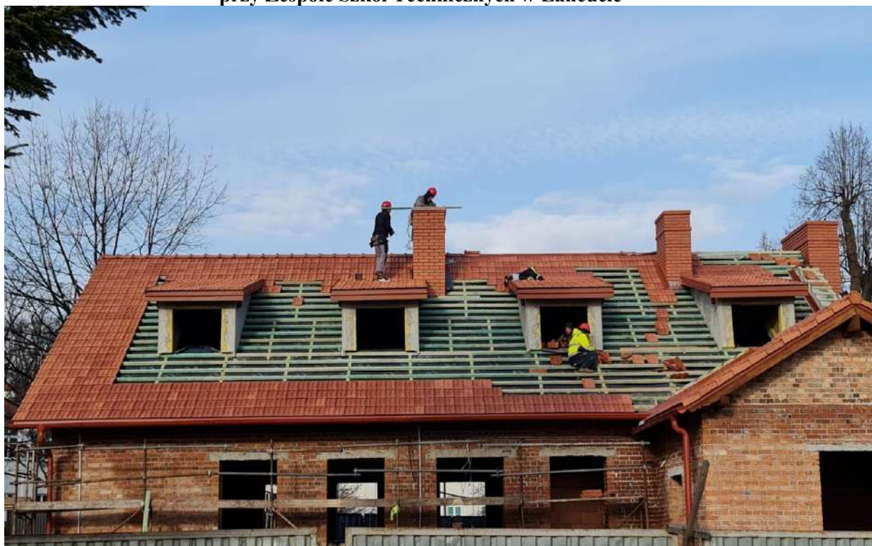
Fotografia 8. Prowadzone prace przy budynku byłej Rządówki przy Zespole Szkół Technicznych w Łąncucie
