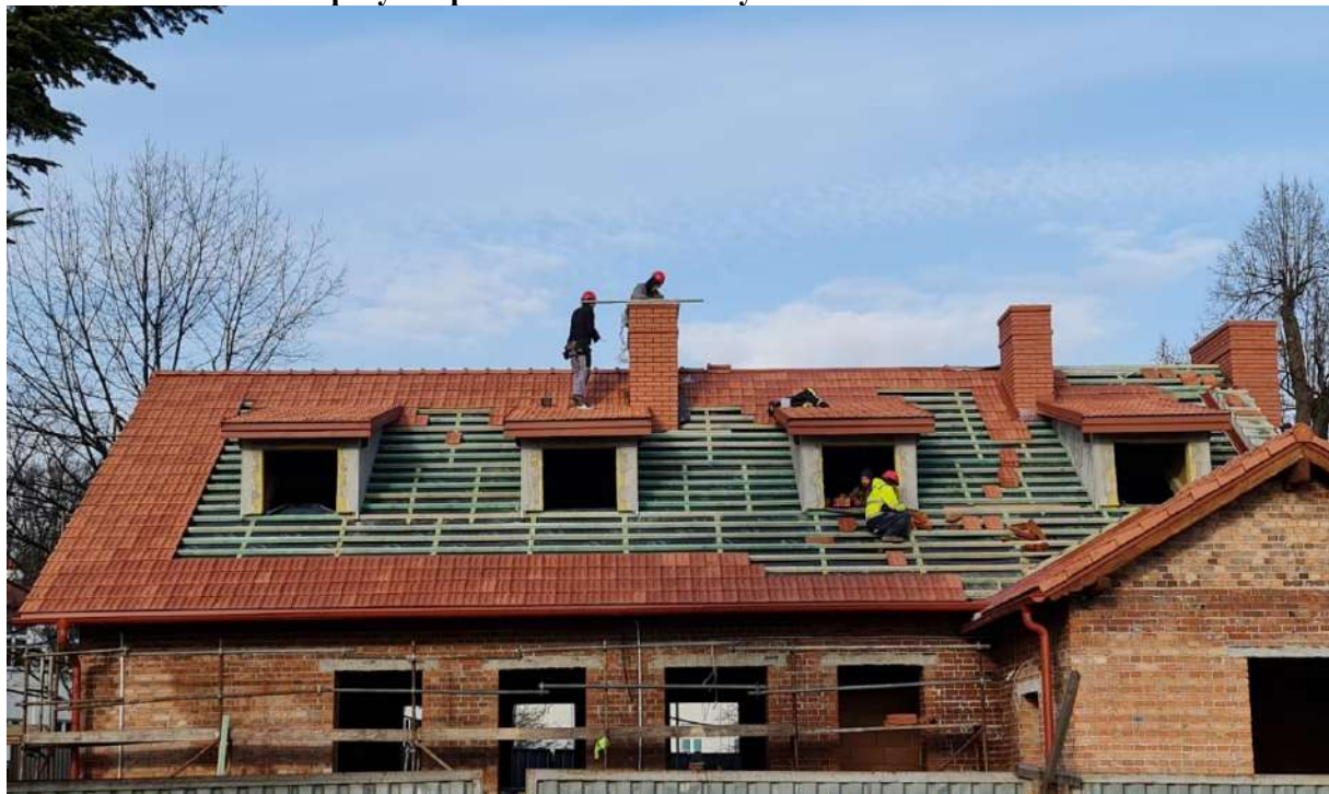
Fotografia 7. Prowadzone prace przy budynku byłej Rządówki przy Zespole Szkół Technicznych w Łąncucie
