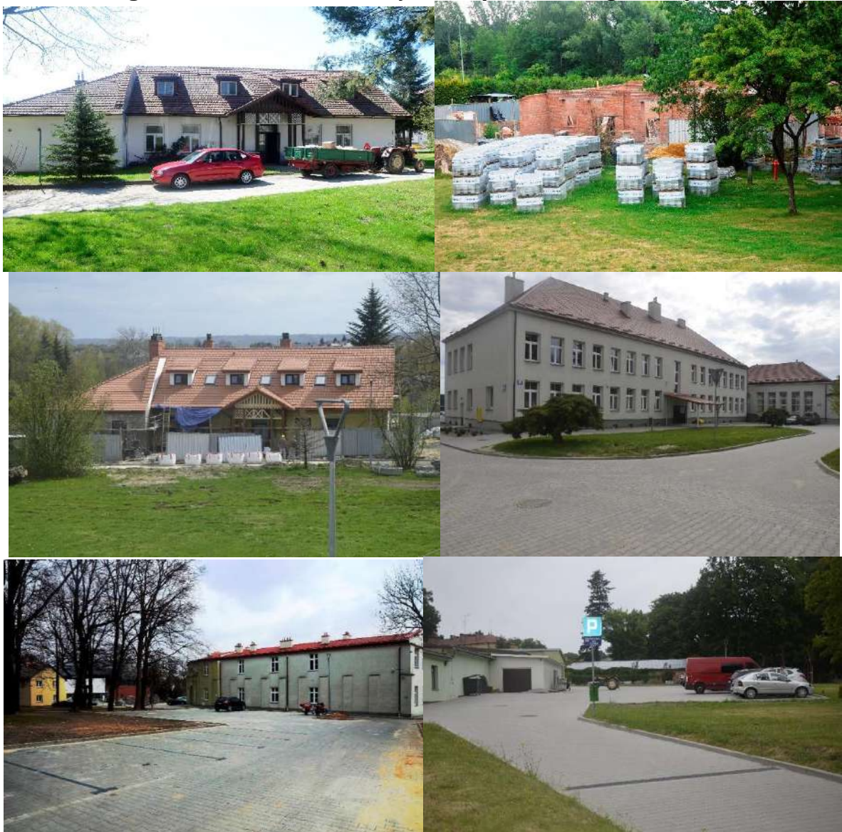
Fotografia 100. Przebudowa budynku Rządcówki i dróg wewnętrznych
