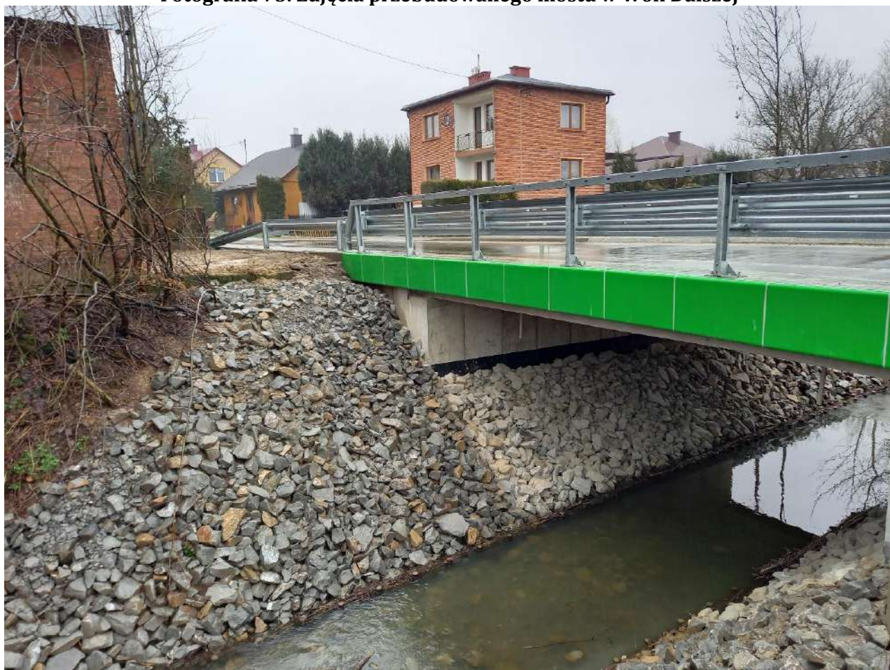
Fotografia 75. Zdjęcia przebudowanego mostu w Woli Dalszej
