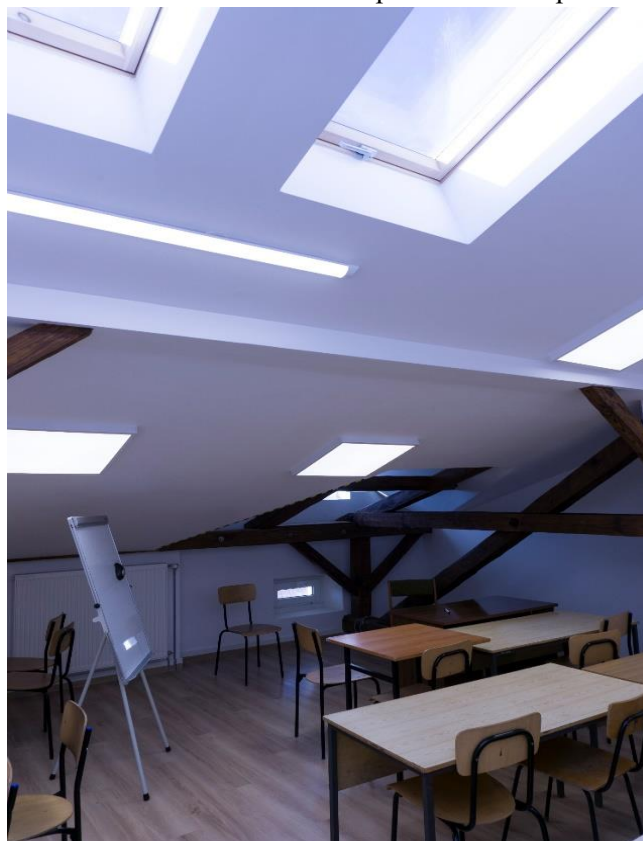
Fotografia nr 76. Widok na odnowione pomieszczenia poddasza szkoły
