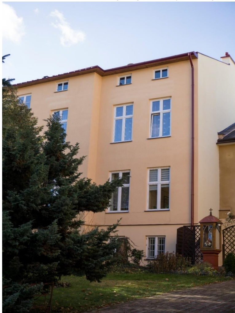
Fotografia nr 74. Widok na odnowiony budynek szkoły od strony wschodniej
