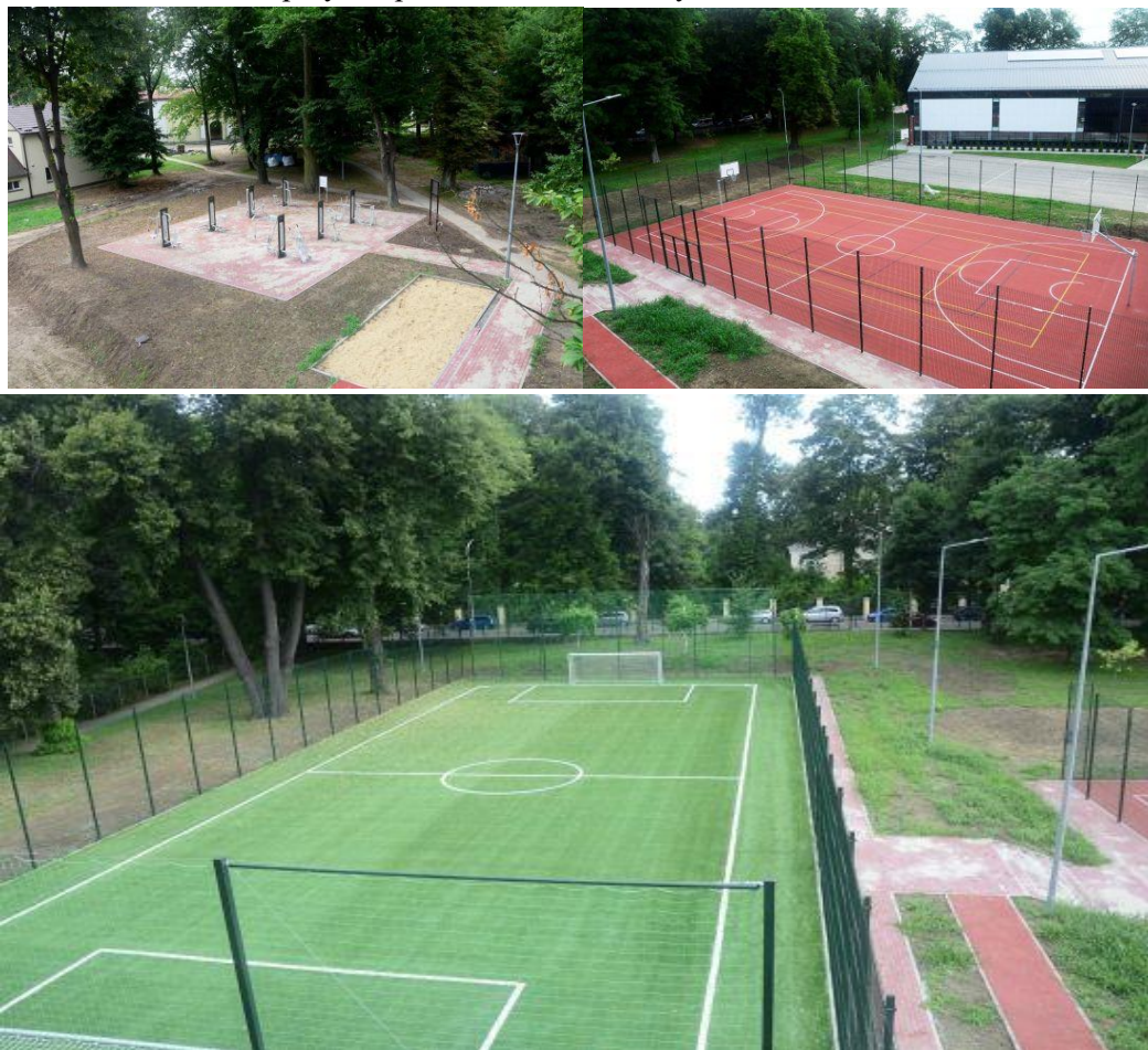
Fotografie nr 99, 100 i 101. Nowo wybudowane boiska przy Zespole Szkół Technicznych w Łańcucie
