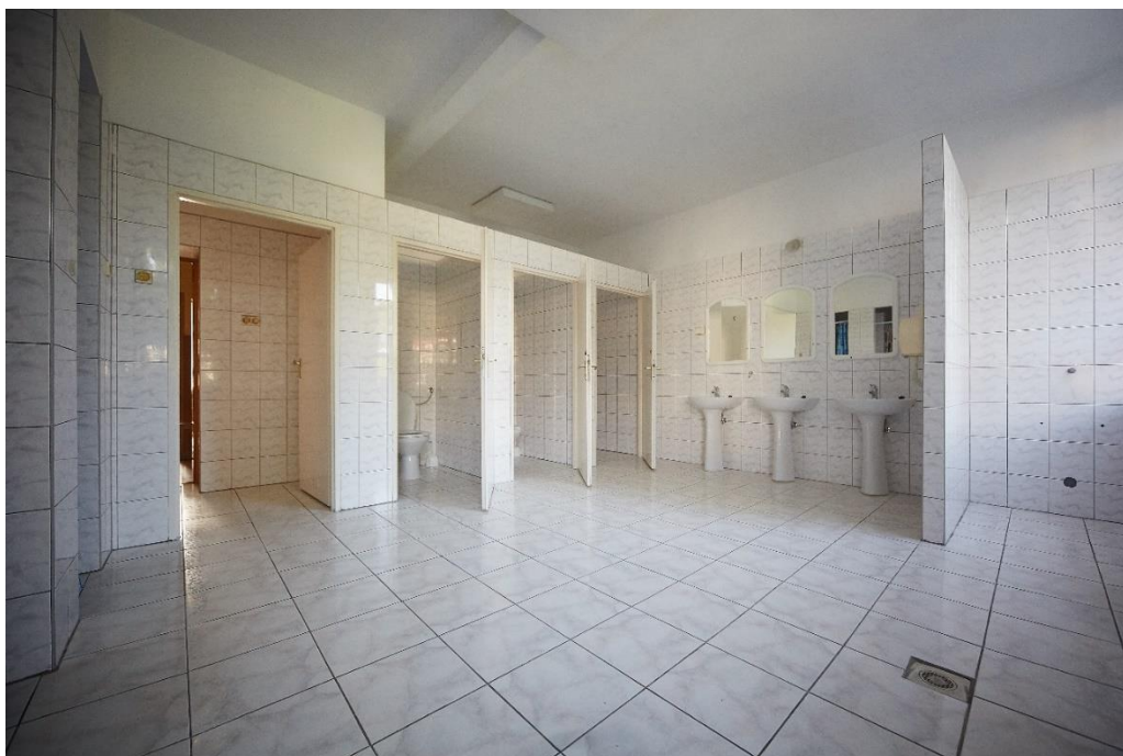
Fotografia nr 91. Wymiana armatury w sanitariatach
