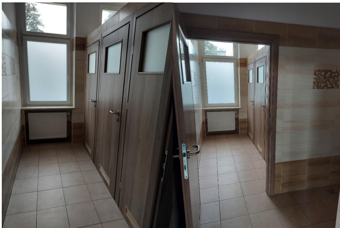
Fotografie nr 59 i 60. Widok wyremontowanych sanitariatów
