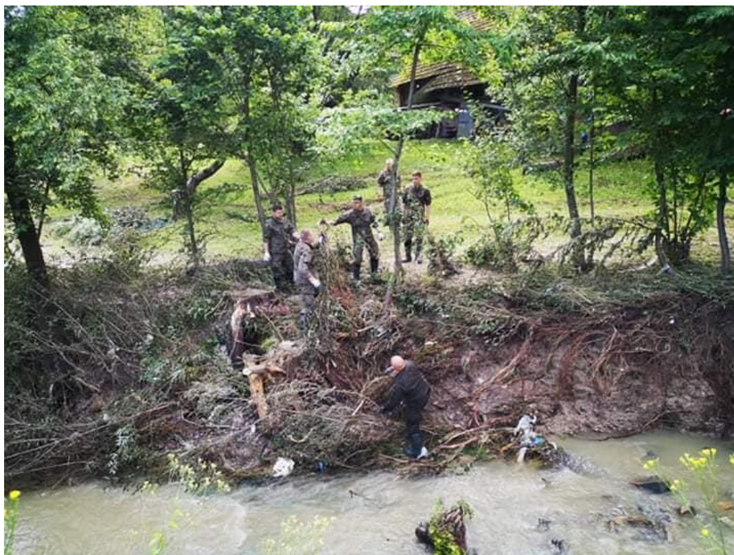
Fotografia nr 49. Usuwanie skutków powodzi
