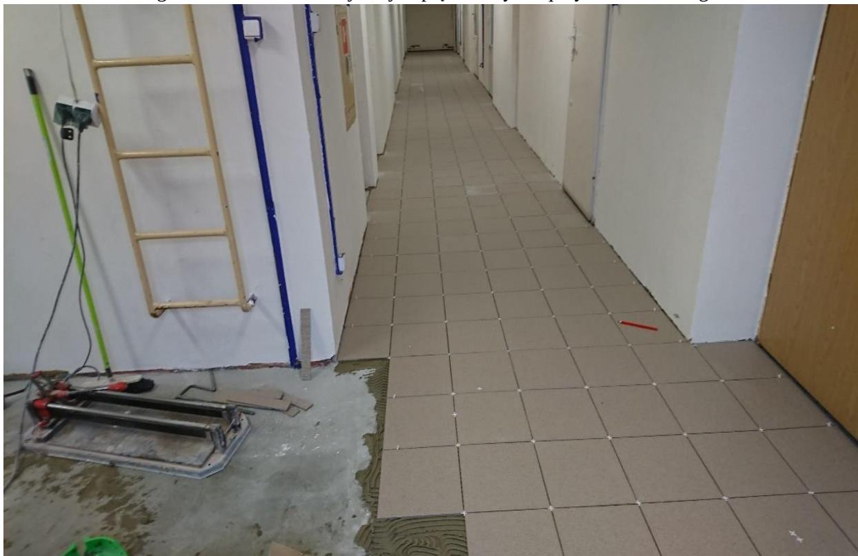
Fotografia nr 3. Remont korytarzy II piętra budynku przy ul. Piłsudskiego 9A
