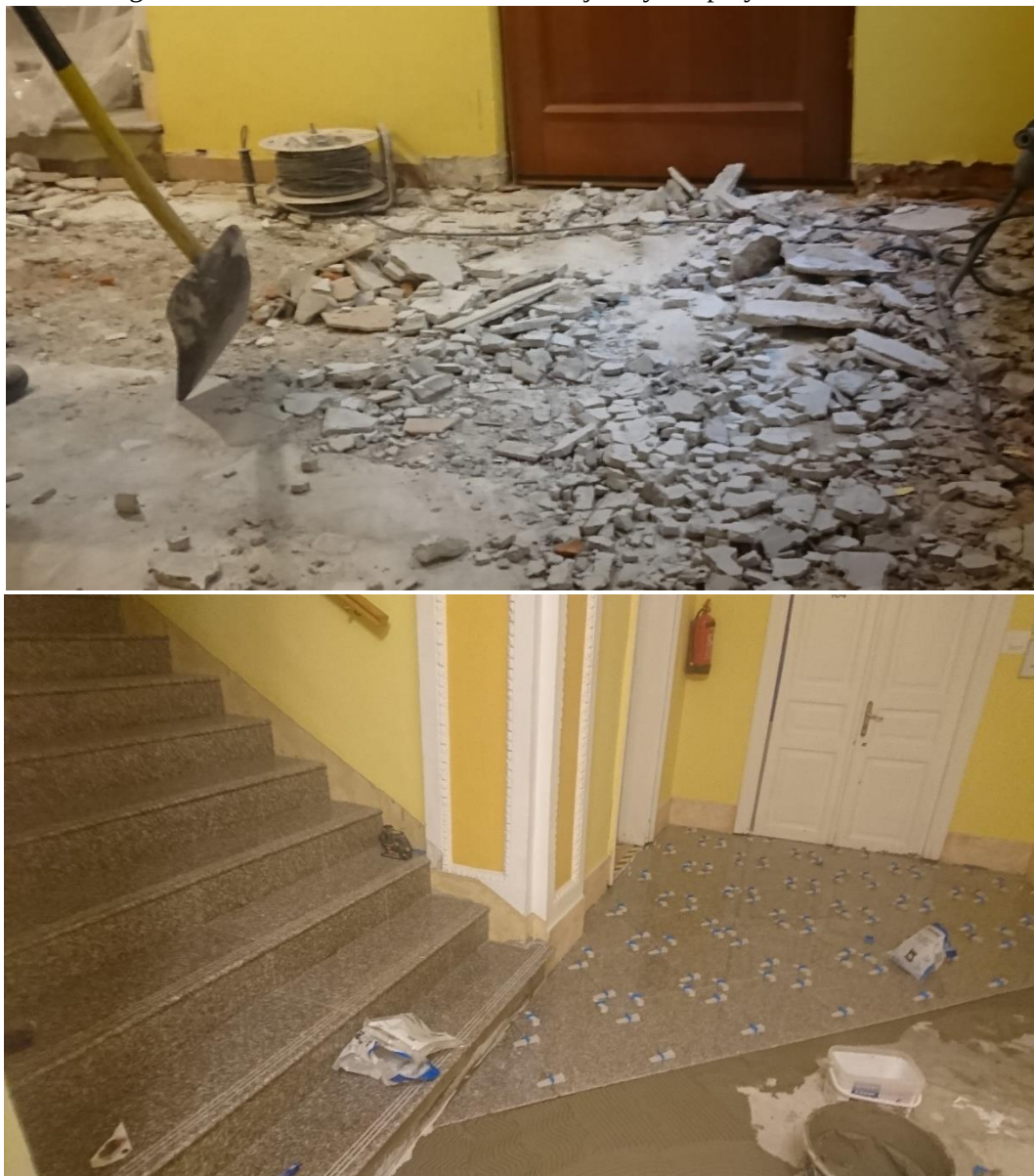
Fotografie nr 4 i 5. Remont klatki schodowej budynku przy ul. Mickiewicza 2
