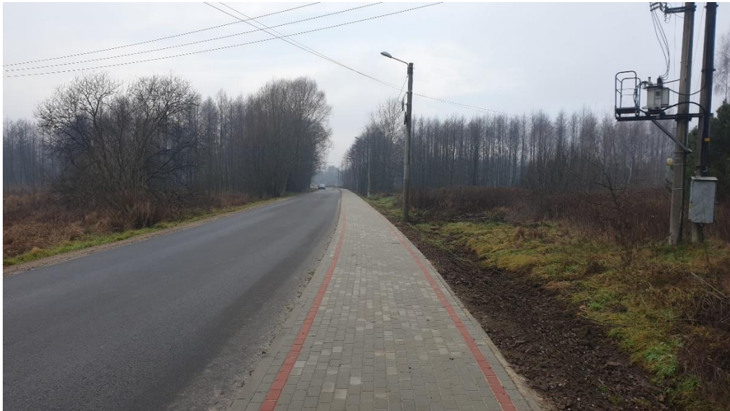
Fotografia nr 55. Przebudowana droga powiatowa nr 1275 R w Budach Łańcuckich
