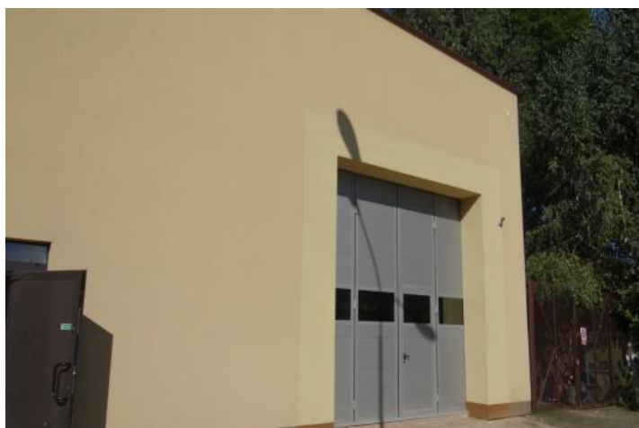
Fotografie nr 98,99,100. Budynek szkoleniowy po przebudowie
