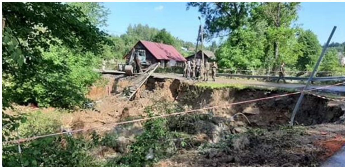
Fotografia nr 51. Usuwanie skutków powodzi
