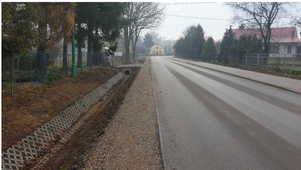
Fotografia nr 56. Przebudowana droga powiatowa nr 1515 R
