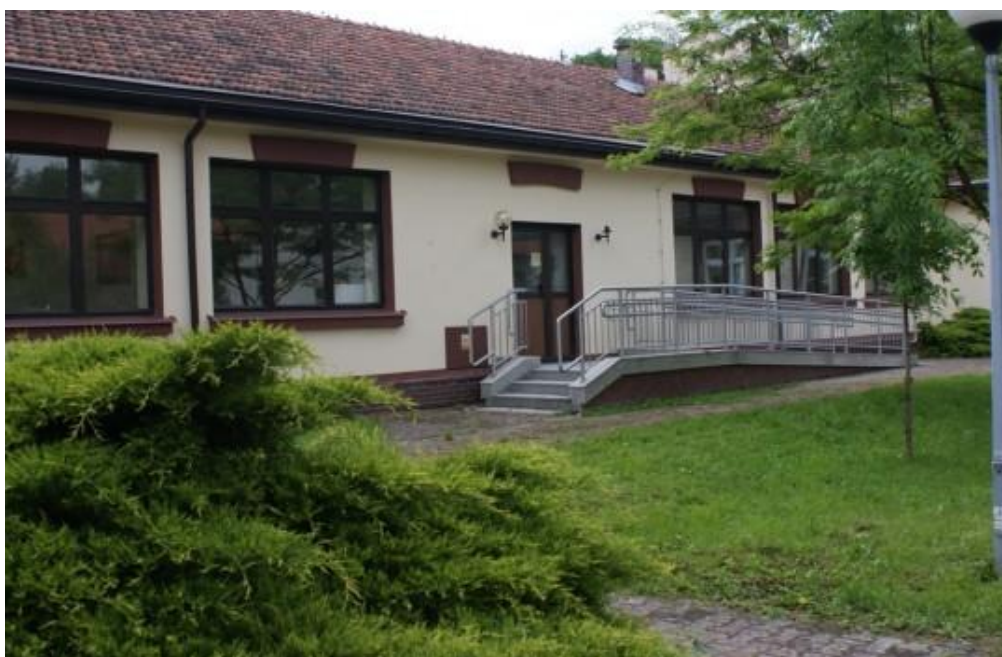
Fotografia nr 49. Budynek Domu Pomocy Społecznej w Łańcucie po remoncie
