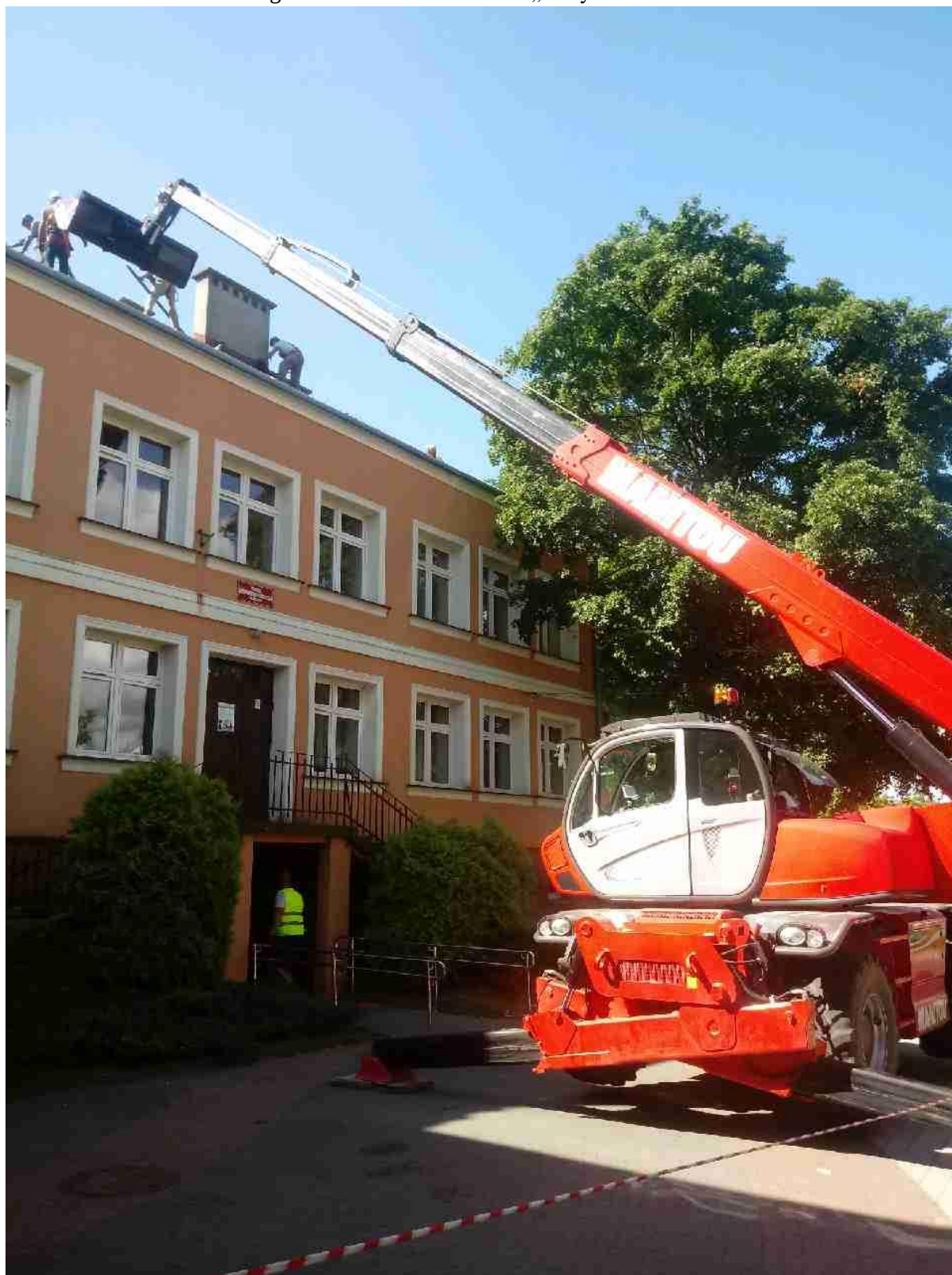
Fotografia nr 36. Remont dachu-„Budynek internatu”
