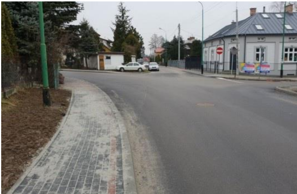
Zdjęcie nr 30. Przebudowana ulica Kraszewskiego w Łąncucie.
