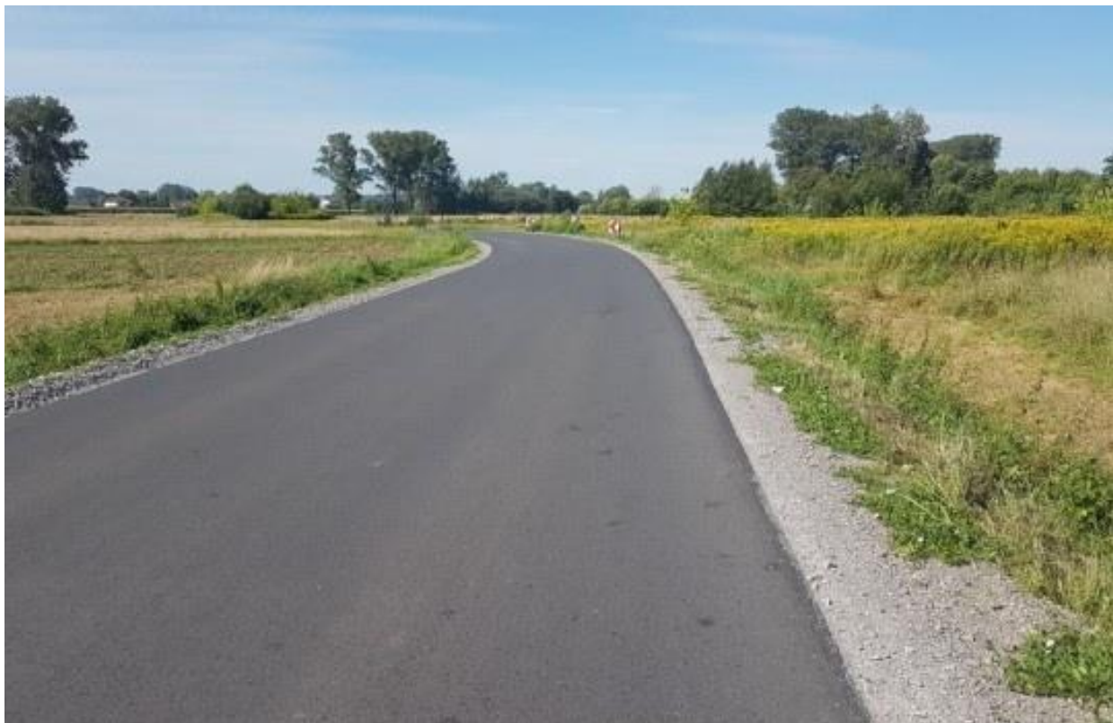
Zdjęcie 32. Przebudowana droga nr 1520R relacji Dąbrówki - Wola Dalsza – Głuchów w miejscowości Dębina.
