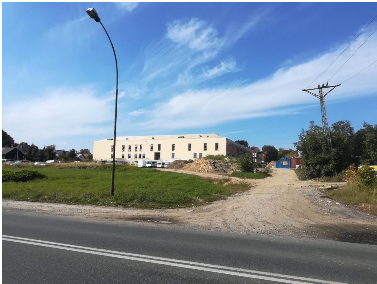
Zdjęcie nr 39. Budowa pawilonu diagnostyczno-zabiegowego.
