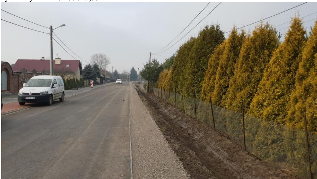
Zdjęcie nr 42. Rozbudowa drogi powiatowej nr 1521R Czarna - Wola Dalsza
