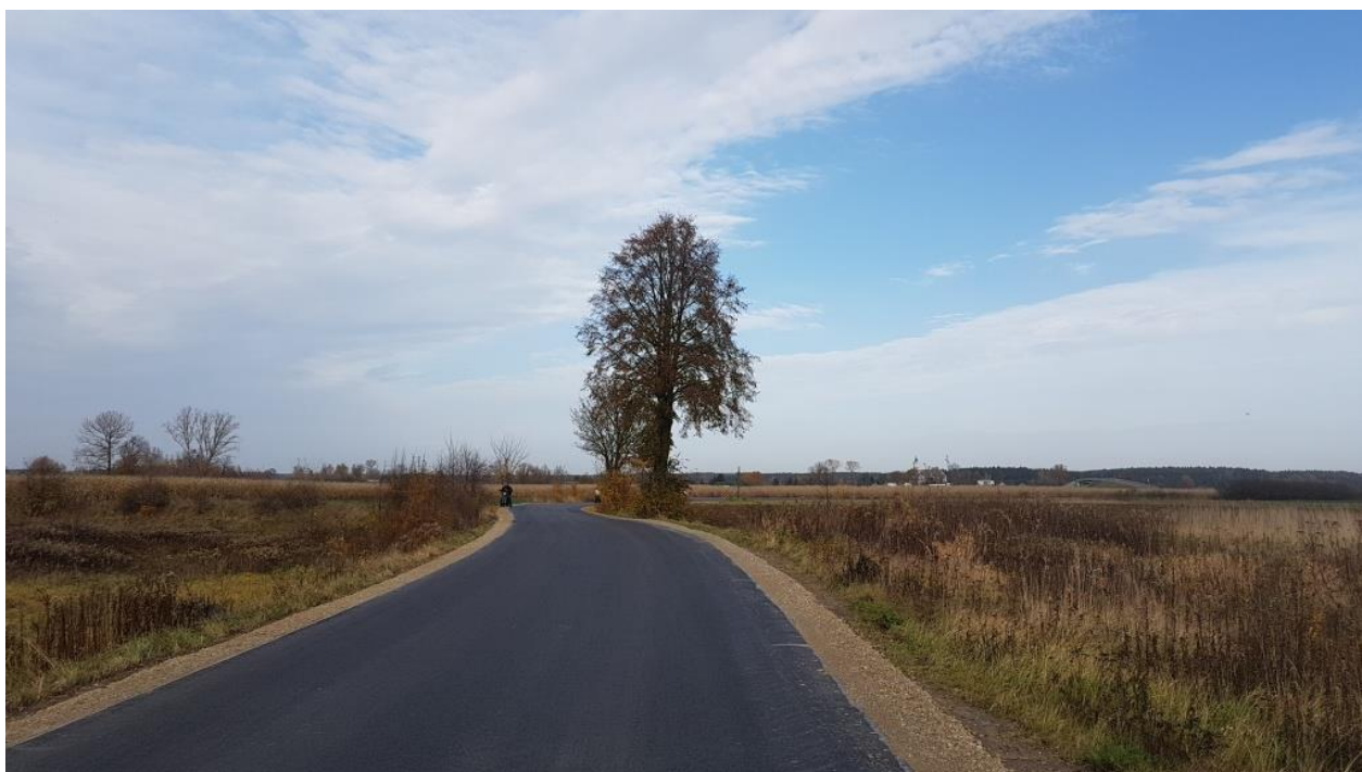
Zdjęcie nr 33. Przebudowana droga powiatowa Nr 1516R relacji Korniaktów Płn. – Budy Łańcuckie.
