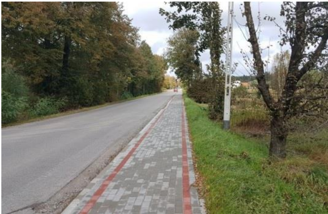
Zdjęcie nr 35. Wybudowany chodni w miejscowości Żołyńia.
