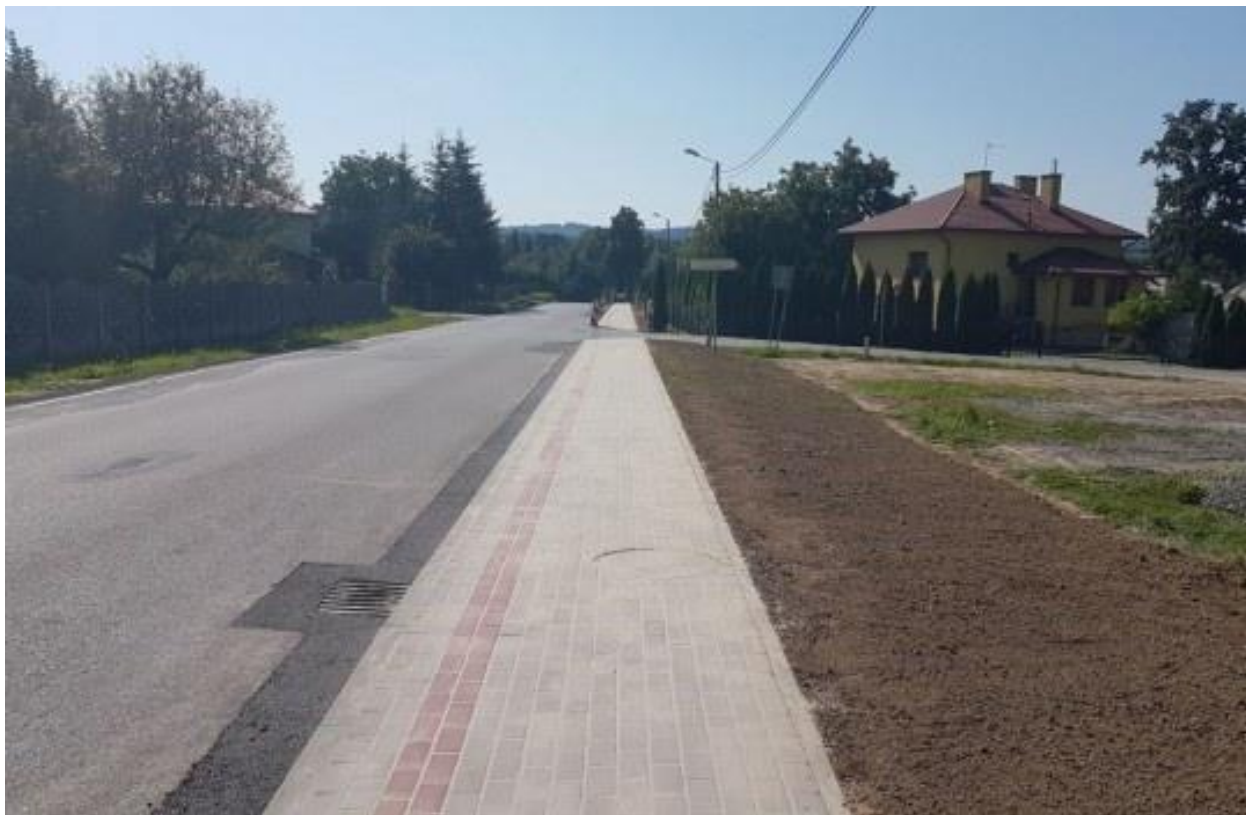
Zdjęcie nr 34. Wybudowany chodnik w miejscowości Kraczkowa.
