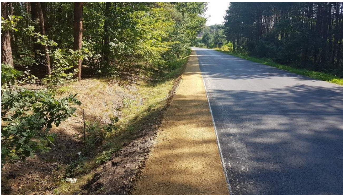
Zdjęcie nr 27. Wyremontowana droga powiatowa nr 1512R Medynia Głogowska – Rakszawa.
