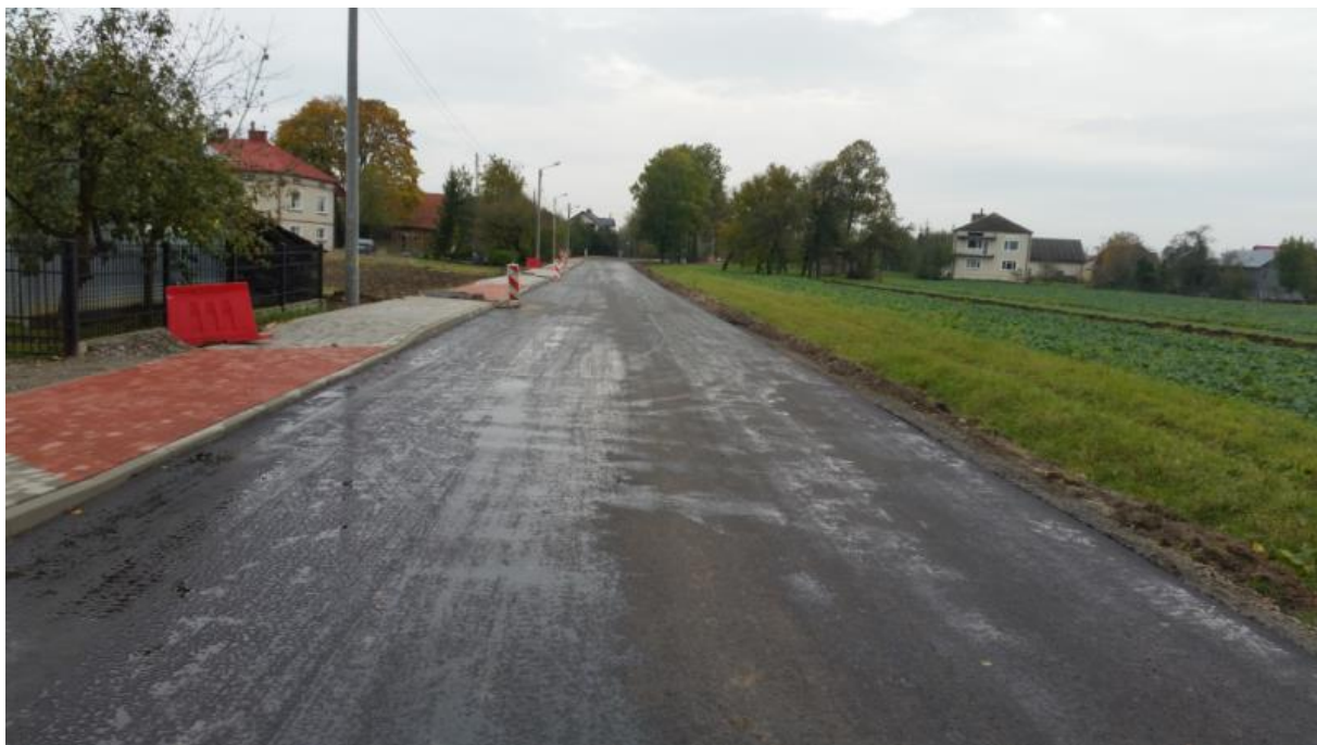
Zdjęcie nr 40 Przebudowa drogi powiatowej Nr 1523 R, Białobrzegi – Kosina
