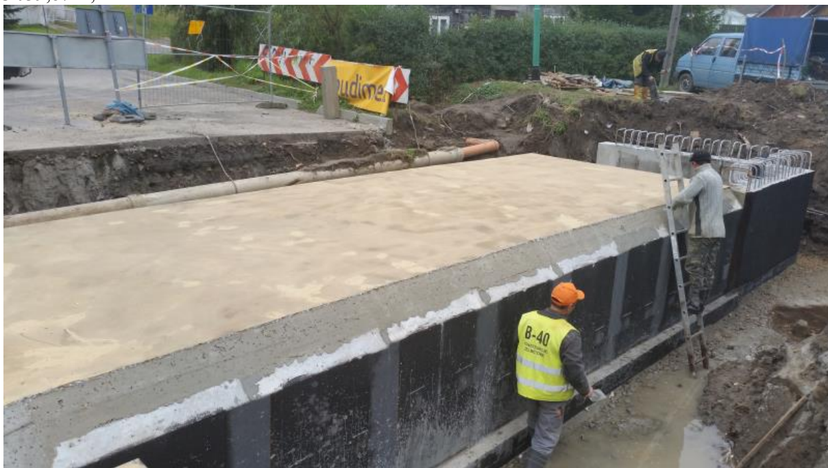
Zdjęcie nr 41 Remont przepustu w ciągu drogi powiatowej Nr 1538R - ul. Konopnickiej w Łąncucie.
