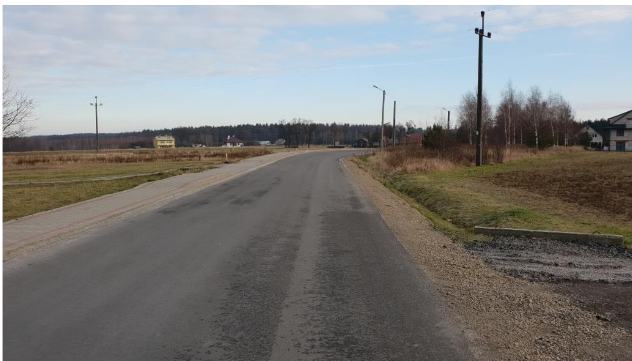
Zdjęcie nr 29. Rozbudowana droga powiatowa nr 1521R Czarna - Wola Dalsza w Czarnej.
