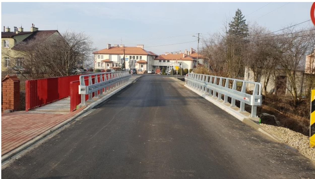
Zdjęcie nr 28. Wyremontowany most na drodze nr 1521R Czarna - Wola Dalsza w Czarnej.
