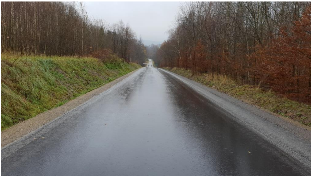
Zdjęcie nr 25. Przebudowana droga powiatowa nr 1546R Husów – Tarnawka.
