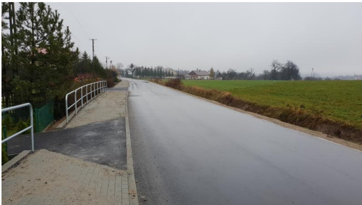
Zdjęcie nr 43. Przebudowa drogi powiatowej Nr 1 546R Husów – Tarnawka.
