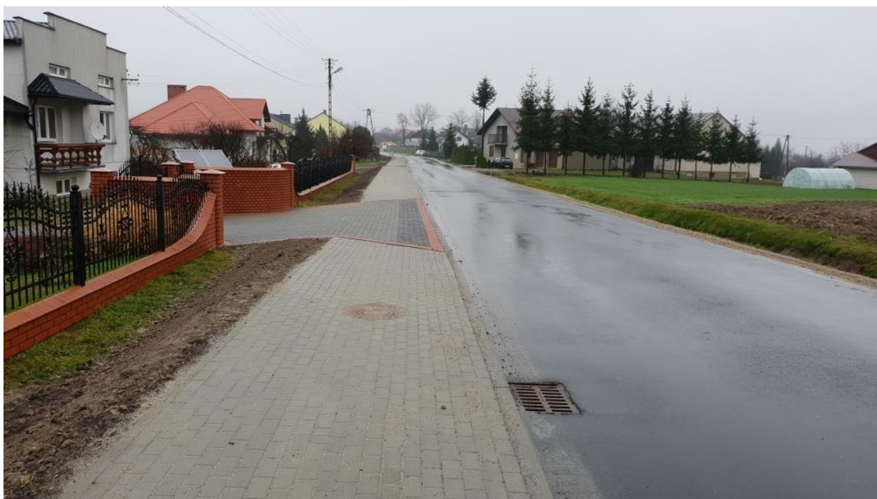
Zdjęcie nr 24. Wybudowany chodnik w miejscowości Husów.
